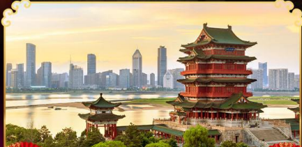
หอเกิงหวังเก้อ
